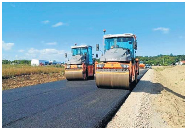
Budowa drogi z Redzikowa do Jezierzyc
