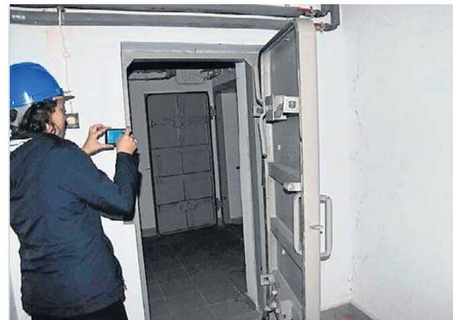
W piwnicy Starej Poczty znajduje się solidny schron
