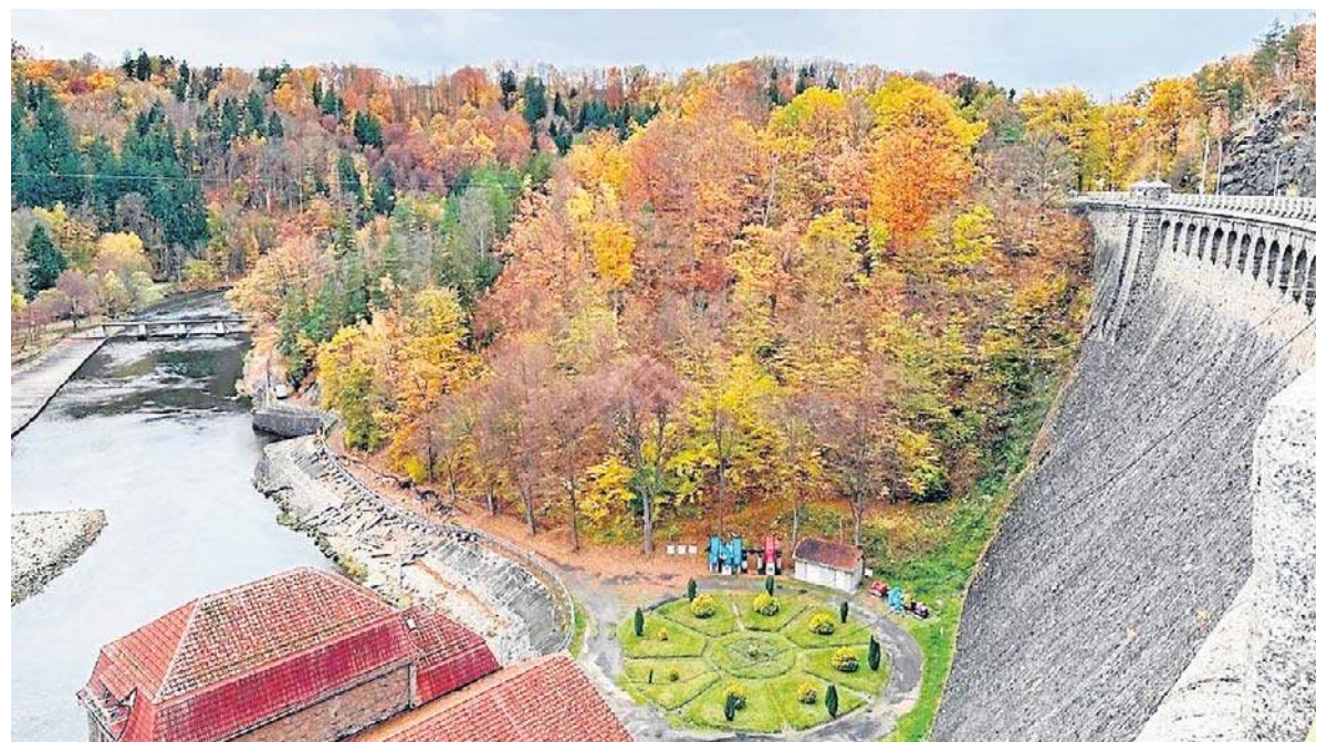
Podczas remontu, wiosną 2026 roku, po raz pierwszy od 50 lat spuszcza wodę z Jeziora Pilchowickiego
