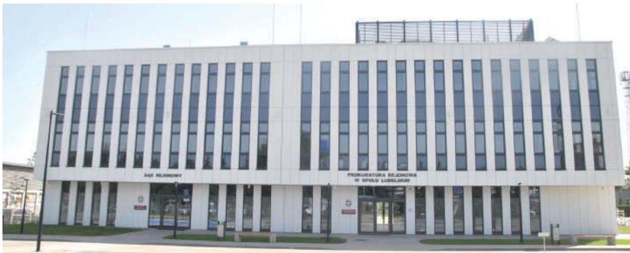
Tak wygląda nowa siedziba opolskiego sądu i prokuratury. Budynek oficjalnie i uroczystie oddany ma zostać do użytku w połowie września
