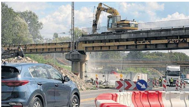
Nie od 24, a od 26 września. Termin zmian na ulicy Łódzkiej w Kielcach został przesunięty przez pogodę
