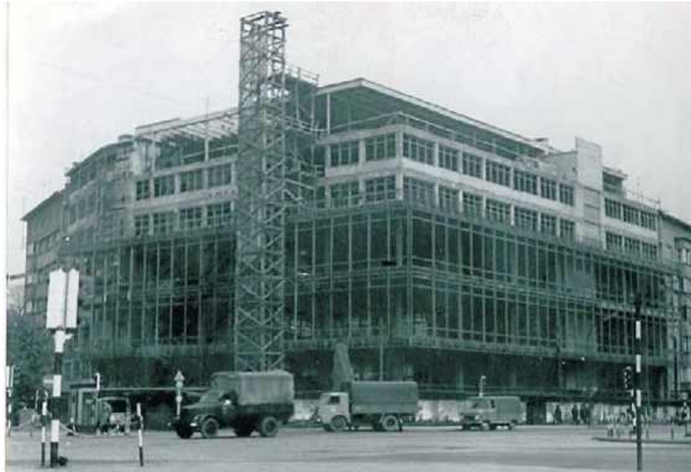
Budowa domu handlowego trwała niemal dziesięć lat
