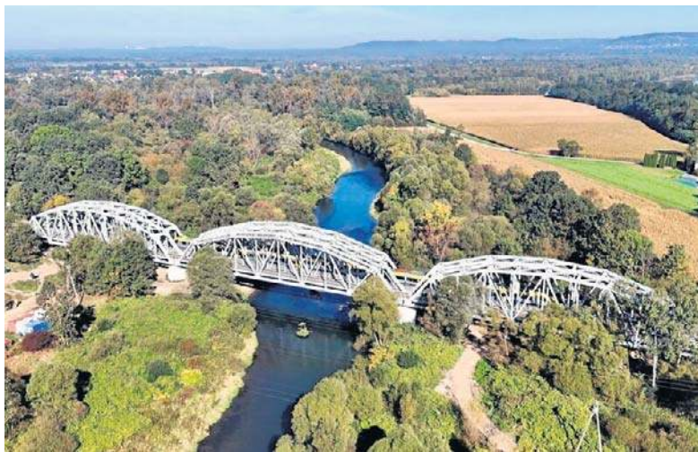
Zakończyła się modernizacja mostu kolejowego w Zatorze
