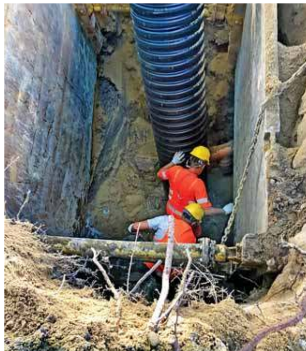
Budowa sieci kanalizacji sanitarnej
