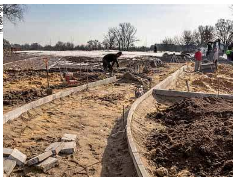
W sąsiedztwie parku wykonywane są miejsca parkingowe
