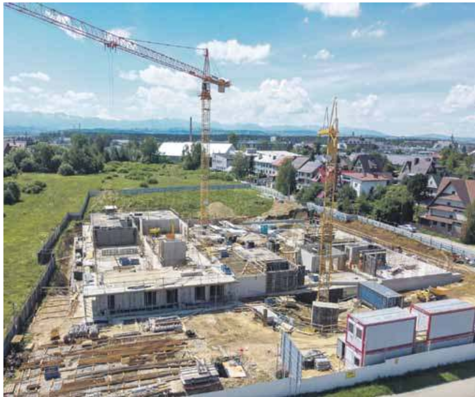
Nowe bloki powstają przy Al. Tysiąclecia, nieopodal ślimaka zakopianki.
