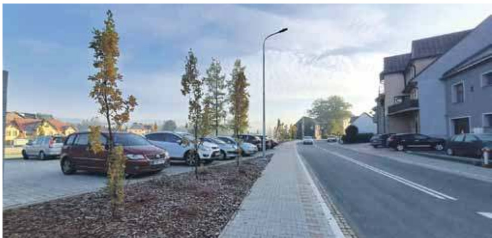
Ulica Nadwodnia wraz z parkingiem - już po generalnym remontcie.
