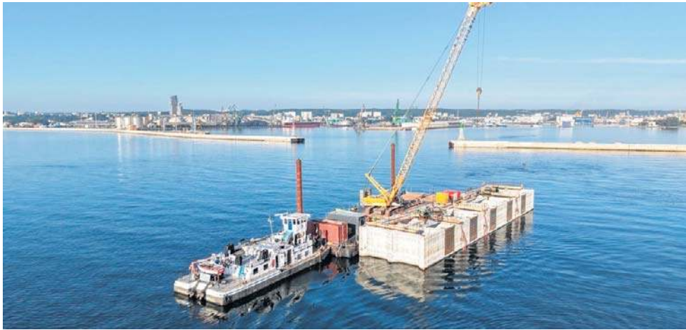
Operacja wodowania pierwszej skrzyni falochronu Portu Zewnętrznego w Gdyni
