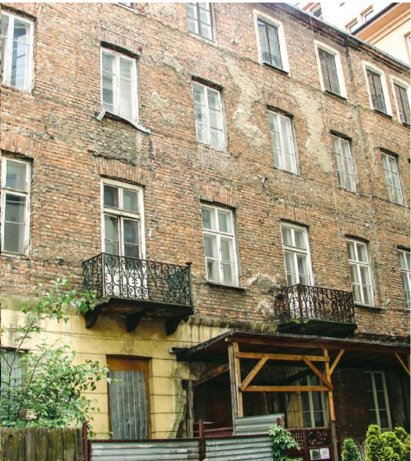
Oficina przy ul. Brackiej 5A i jeden z balkonów budynku | fot. Janusz Sujecki/Gazeta Polska
