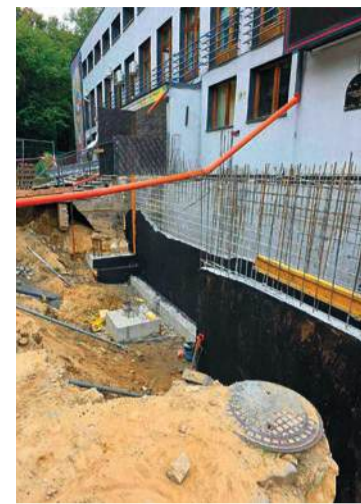
Intensywne prace przy ciechanowskim domu kultury
