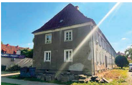
Blok przy ulicy Okrzei 5
