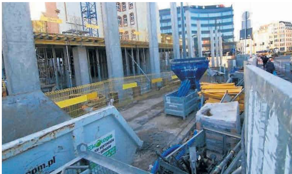
Elementy konstrukcji przejścia są już widoczne. Na czas jego przebudowy, piesi korzystają z naziemnego, tymczasowego przejścia dla pieszych. Z lewej widoczne filary biurowca
