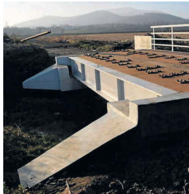
Gruntownie odnawiane obiekty inżynierskie, mosty czy przepusty
