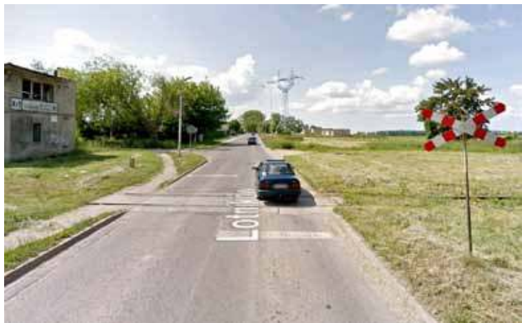
W związku z remontem przejazdu kolejowego w ciągu ul. Lotników kierowcy muszą korzystać z objazdów
