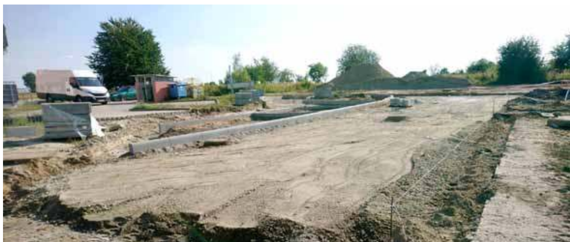
Na Osiedlu Pyrzyckim trwa inwestycja drogowa polegająca na budowie kolejnego odcinka ulicy Pileckiego
