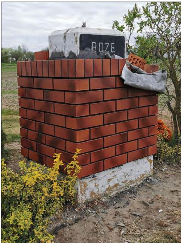
Dotychczasowa kapliczka została obudowana cegłą klinkierową na starym fundamencie
