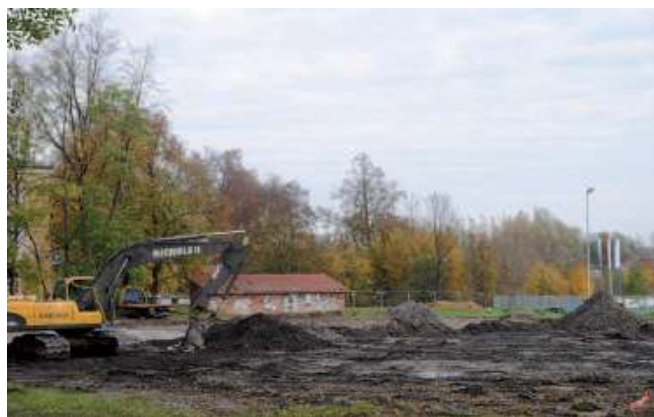
Pierwsze prace zaczęły się od wycinki drzew i wykopów
