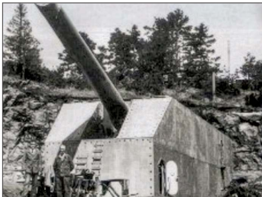
Armata kal. 380 mm Mle 1935 w wieży na schronie-stanowisku bojowym typu S 536 baterii Nötteröy .
