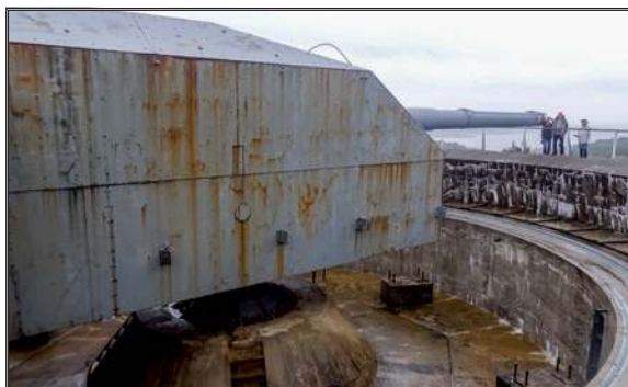
Armata kal. 380 mm SK C/34 baterii Kroodden/Vara w wieży na schronie stanowisku bojowym typu S 169.
