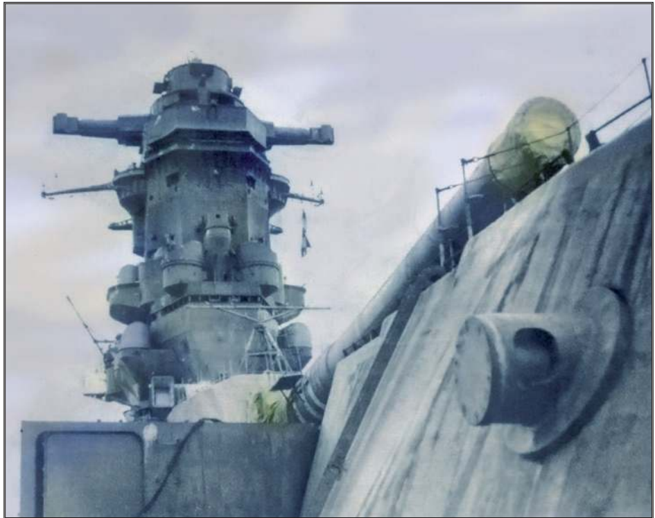
Wieża artylerii głównej kal. 460 mm nr 1 i nr 2 oraz przednia nadbudówka pancernika Musashi , sfotografowane na przełomie czerwca i lipca 1942 r.
