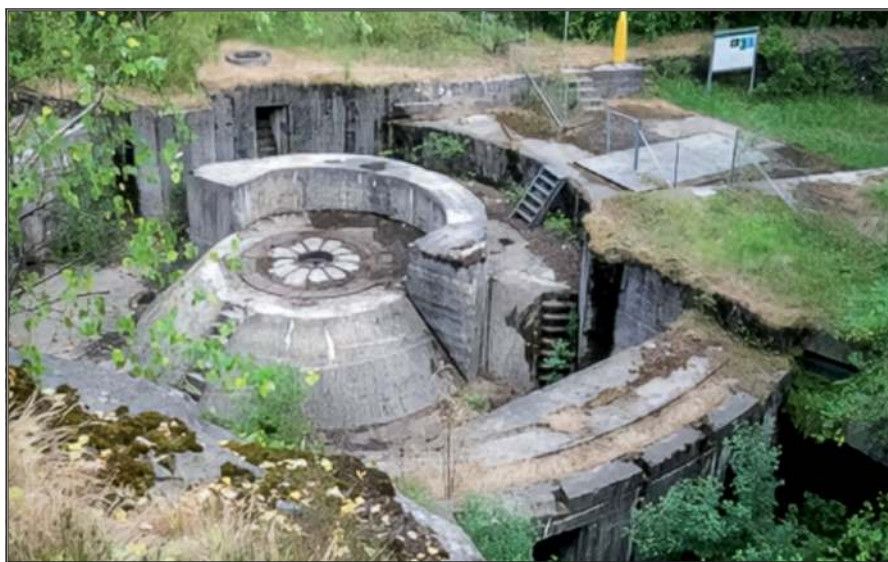
Jeden z dwóch istniejących schronów-stanowisk bojowych typu S 536 baterii Nötterøy .
