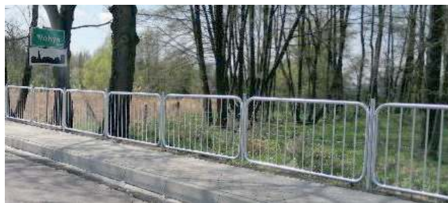
Oprócz chodnika wykonano m.in. balustrady
