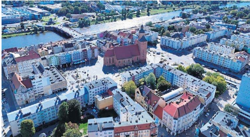
Pierwsze miejsce na liście ważnych budynków Gorzowa zajmuje katedra. „Mia100” to kolejna część współpracy między miastem a instytutem architektury i urbanistyki UZ
