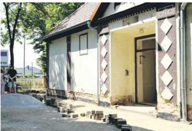
Przedszkole w trakcie remontu
