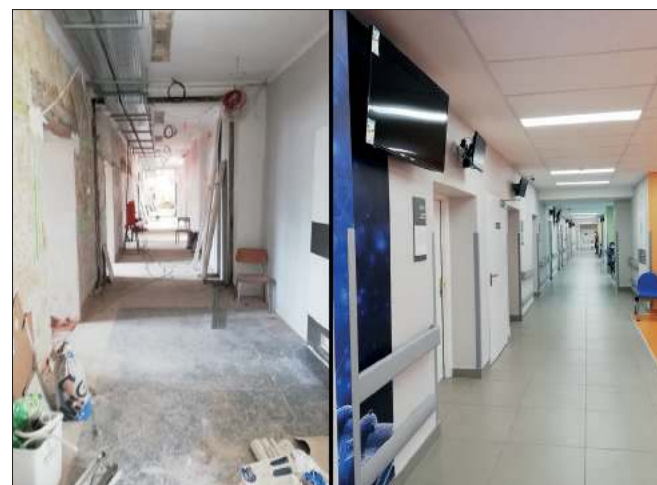
Jeden z korytarzy w czasie remontu oraz po jego zakończeniu
