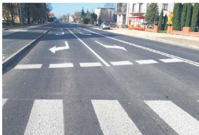
Ulica Okrzei po zakończeniu wyjątkowo długiego i uciążliwego remontu. Fot. UM Zamość
