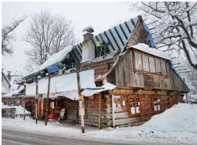
Kończy się remont dachu na zabytkowym domu Wnuka.
