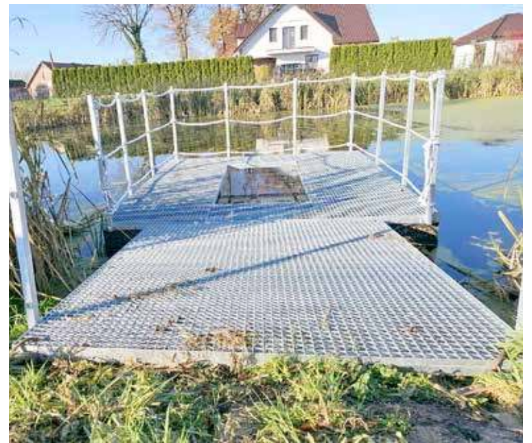
W Redle na zbiorniku ppoż. zamontowano podest pływający
