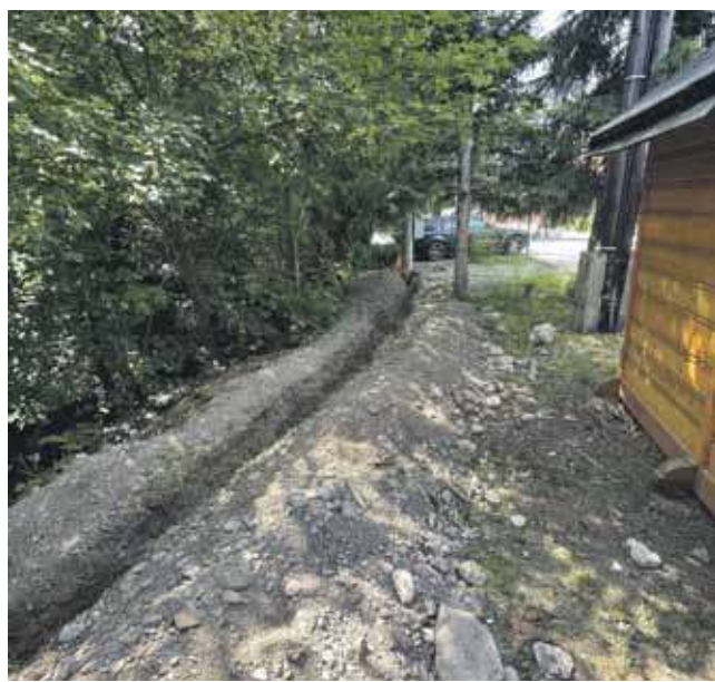
Niedawno z bud poprowadzono wykop do pobliskiego słupa energetycznego.
