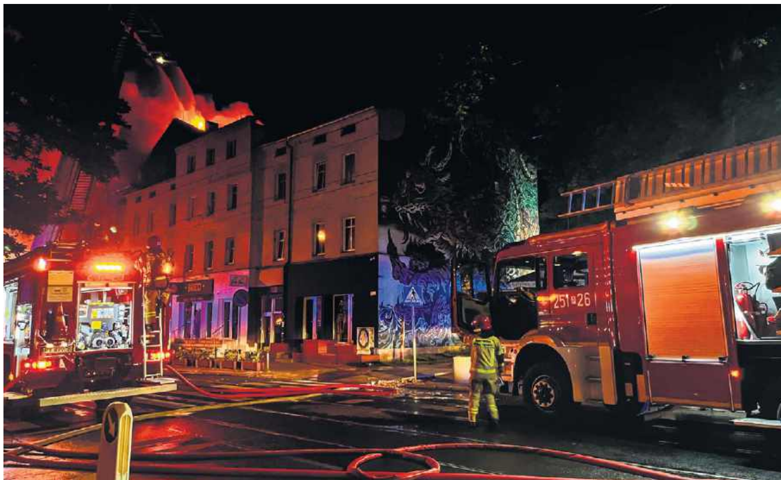
W nocy z 24 na 25 sierpnia 2024 roku pożar i dwa wybuchy zniszczyły kamienicę przy ul. Kraszewskiego 12 w Poznaniu
