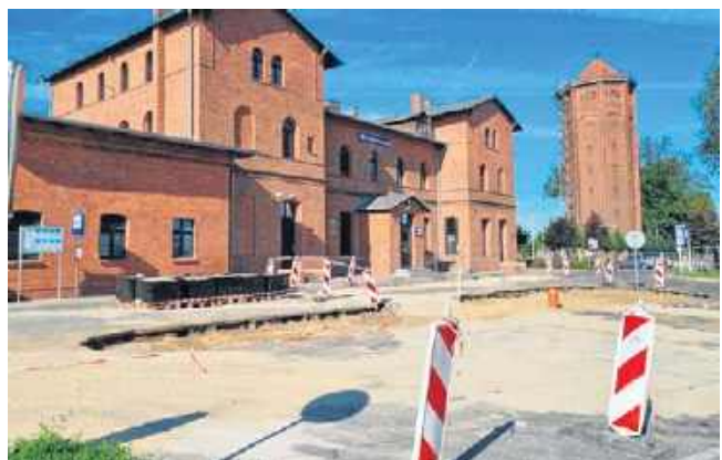
Remont terenu przed dworcem kolejowym w Kowalewie.
