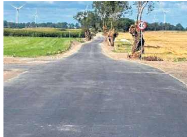
Odbiór zadania drogowego „Przebudowa drogi Jezioroki – Czesławice – I etap” w gminie Gołańcz.
