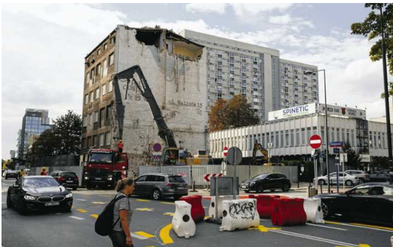
• Rozbiórka kamienicy przy Grzybowskiej 46 FOT. DAWID ŻUCHOWICZ / AGENCJA WYBORCZA.PL
