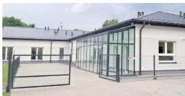
Po uzyskaniu wszystkich wymaganych decyzji administracyjnych obiekt będzie gotowy na przyjęcie pierwszych dzieci
