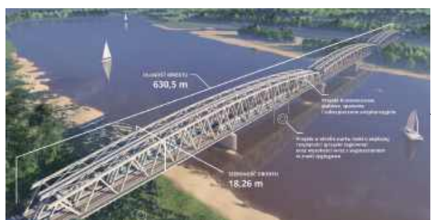
Powrót pociągów pasażerskich na trasę Czachówek Wschodni – Pilawa, nowy most kolejowy nad Wisłą, szybsze połączenia i modernizacja infrastruktury wartę około 1,3 mld zł właśnie zrobiły ważny krok naprzód
