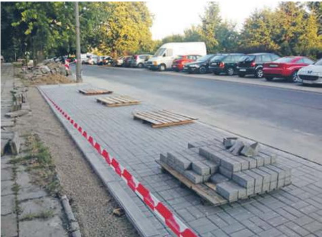
Rozbudowa parkingu przy ulicy Kazimierza Wielkiego jest już zakończona
