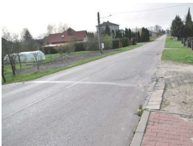
Firma, która wygra przetarg, będzie miała czas do końca lipca na wybudowanie chodnika przy ul. Szkolnej
