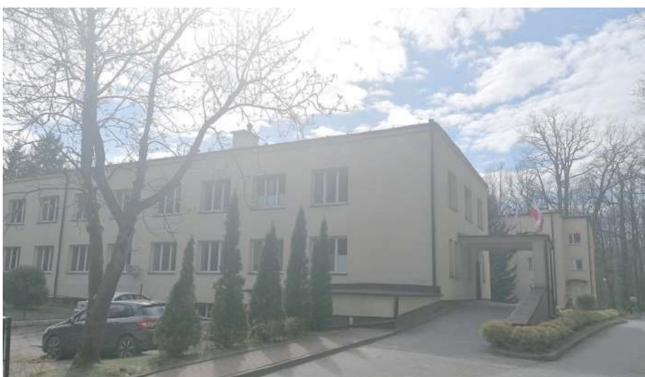
Inwestycja zakłada m.in. modernizację bloku A, w którym leczone są choroby płuc i bloku B, w którym leczone są gruźlice
