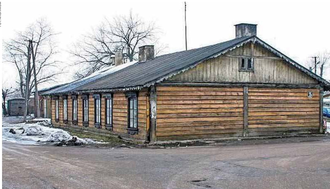
Zabytkowy budynek kolejowy postawiono w 1880 r.
