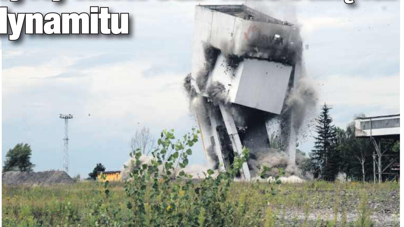
■ Wyburzenie wieży szybowej Jas II po byłej KWK Jas-Mos. 19.08.2026 r.
