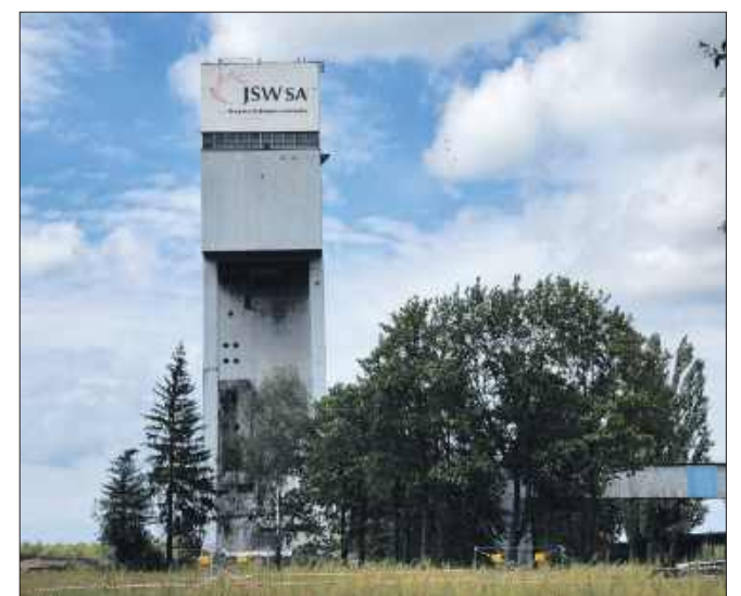
■ Wieża szybowa na kilka minut przed detonacją
