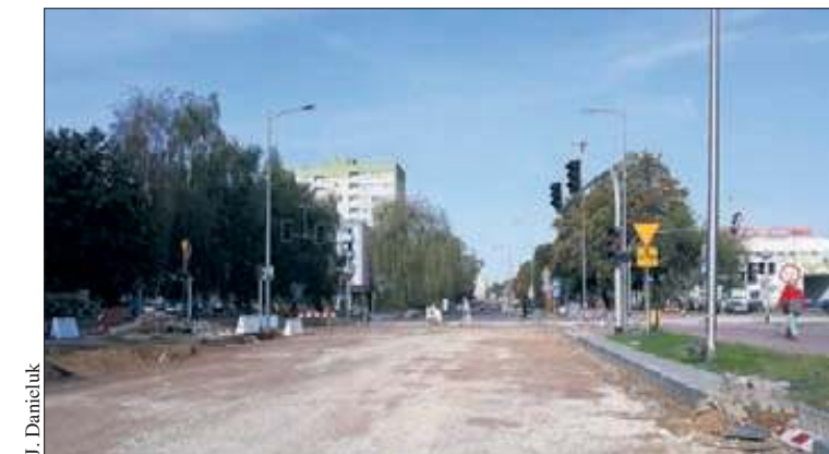
Prace na skrzyżowaniu ul. Tysiąclecia i Rembielińskiego trwają
