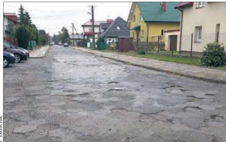
Planowany termin zakończenia prac na ul. Maneżowej to 31 marca przyszłego roku
