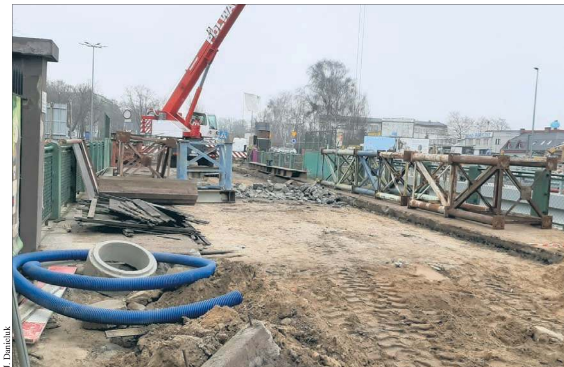
Trwa rozbiórka starego wiaduktu przy ogrodzie zoologicznym
