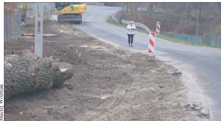
Ulica Pocztowa w czasie remontu
