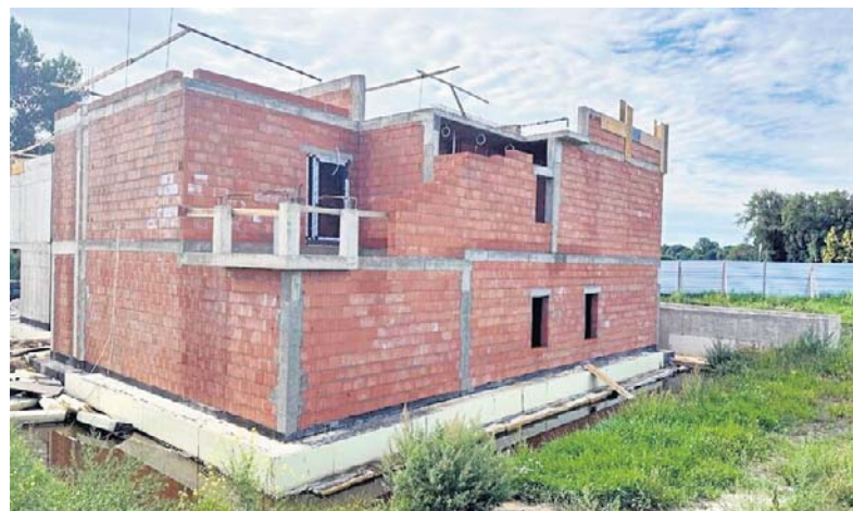
Po rozwiązaniu wielu problemów technicznych ruszyła odbudowa Starego Młyna.
