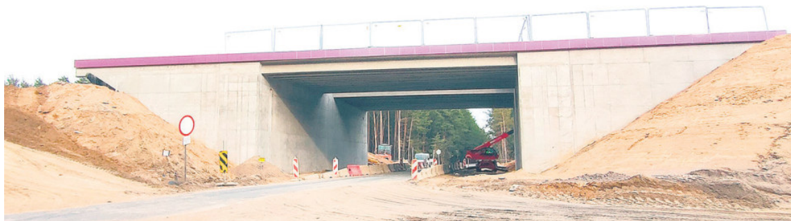
Na terenie powiatu łosickiego istnieje obecnie jedynie niewielki fragment trasy S19. Na zdjęciu wiadukt nad drogą w Kózkach.
