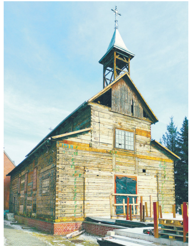
Kościół w Dęblinie podczas rozbiórki
