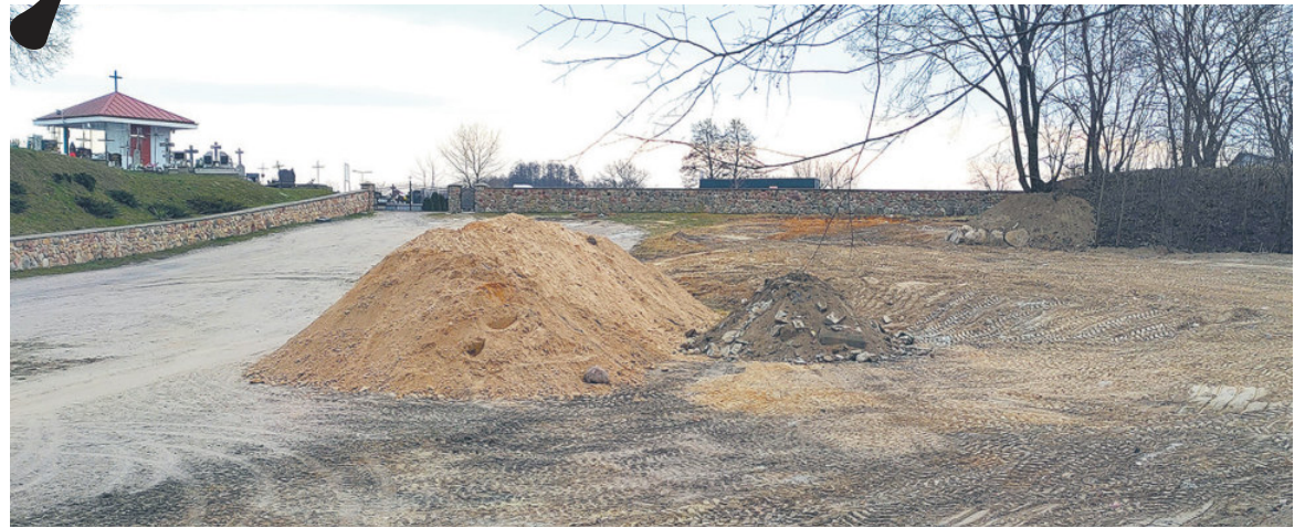
Przy cmentarzu w Łosicach rozpoczęto już prace. Tu stanie świątynia.
