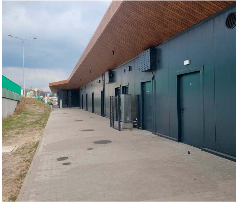
Wejścia do lokali użytkowych trzebińskiego dworca autobusowego, czekających na najemców
