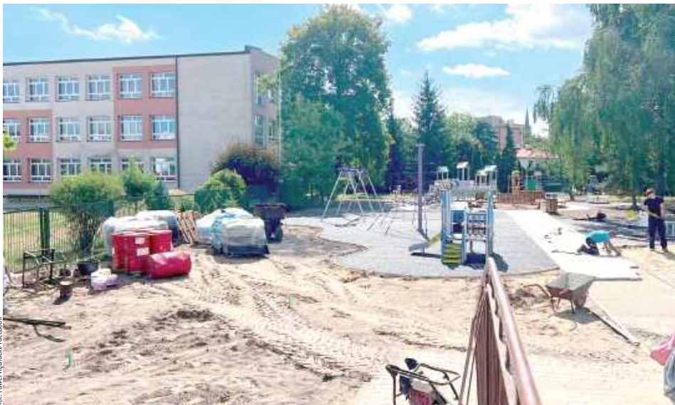
Wartość inwestycji wynosi 1 446 480 zł. Wykonawcą robót jest firma ERES Piotr Szymański
