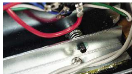
Główną płytę „podwieszono” na sprężynowych tłumikach drgań.
