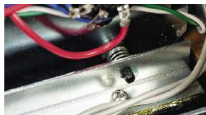
Główną płytę „podwieszono” na sprężynowych tłumikach drgań.
