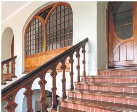
Zabytkowe schody wraz z balustradami odzyskały dawny blask
