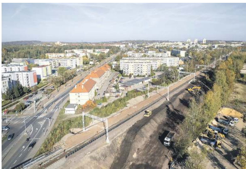
Lini kolejowa nr 131 dzieli Bytom na części. Teraz wreszcie doczekała się rewitalizacji
