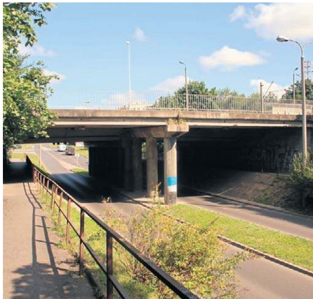
Wykonawca będzie miał rok na realizowanie inwestycji związanej z remontem wiaduktu
