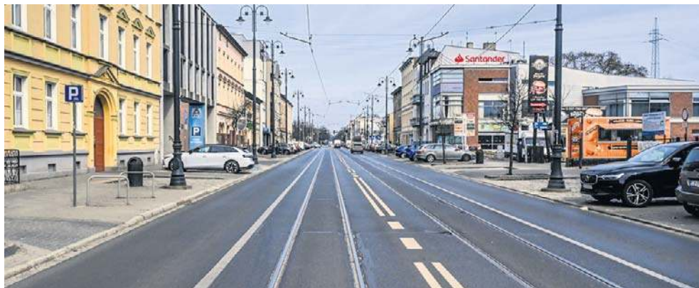
Dwa nowe przystanki wiedeńskie wybudowane zostaną na odcinku pomiędzy ulicą Chodkiewicza a ulicą Kamienną
