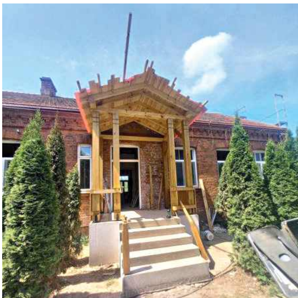
Fot. Beata Malczuk Zakres remontu plebanii obejmował m.in. odnowienie i odtworzenie stolarki okiennej oraz drzwiowej, wymianę parapetów, a także przywrócenie ganku wejściowego wraz ze schodami
