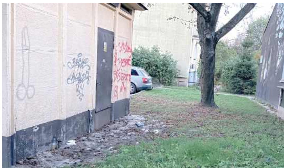
Tak wyglądał teren, gdy zjawiliśmy się na miejscu. Było pełno śmieci i butelek
