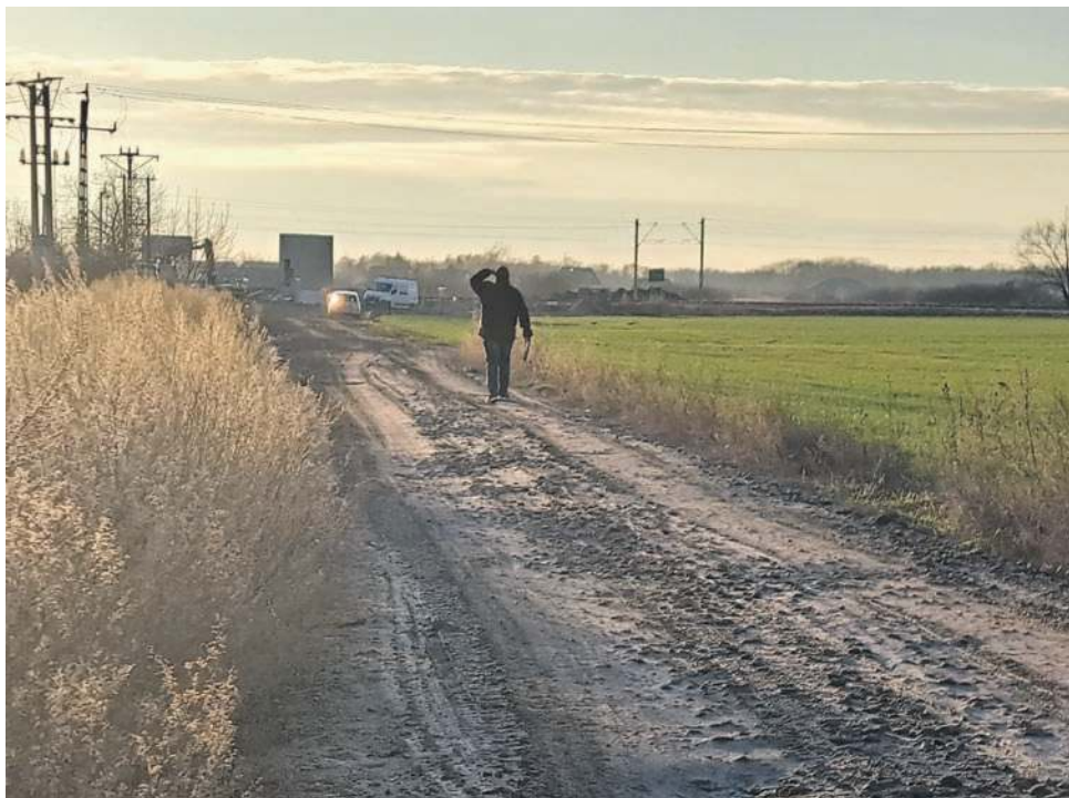
Teraz do budowanej stacji Oława Zachodnia prowadzi polna droga, ale za kilka miesięcy ma być asfaltowa, a po jej prawej stronie Centrum Przesiadkowe z parkingami dla różnych pojazdów i przystankiem autobusowym
