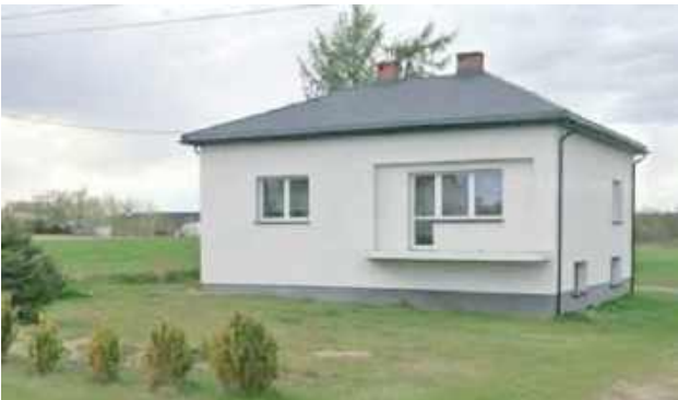
Rodzina chce odbudować dom i ponownie urządzić go tak, by można było w nim normalnie żyć. Mają miejsce, na którym chcieliby rozpocząć nowy etap oraz gotowość do pracy. Brakuje jednak pieniędzy na realizację tych planów
