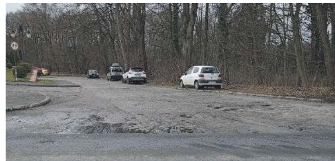
W tym miejscu, przy wjeździe do placówki Taurona, łączyć się będzie ul. Energetyczna z ul. Trzebnicką
