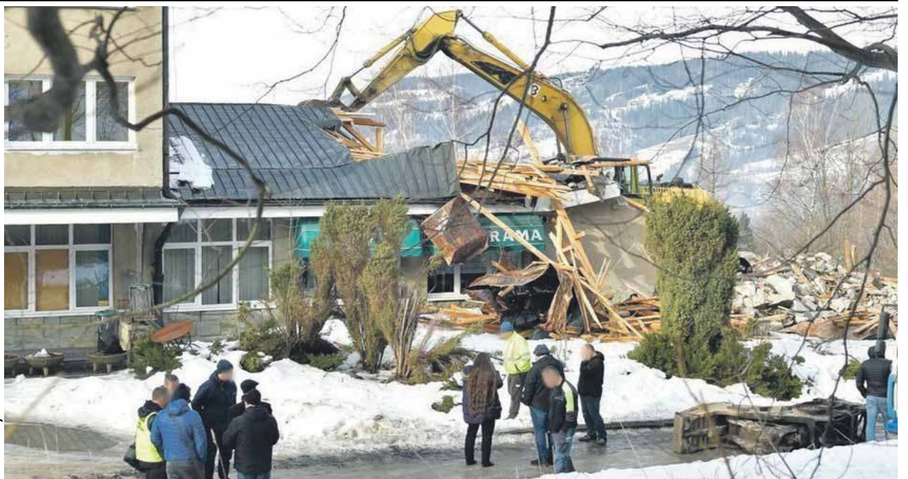
Policja, prokurator, nadzór budowlany na miejscu nielegalnych prac rozbiorowych przy ul. Wierchowej.
