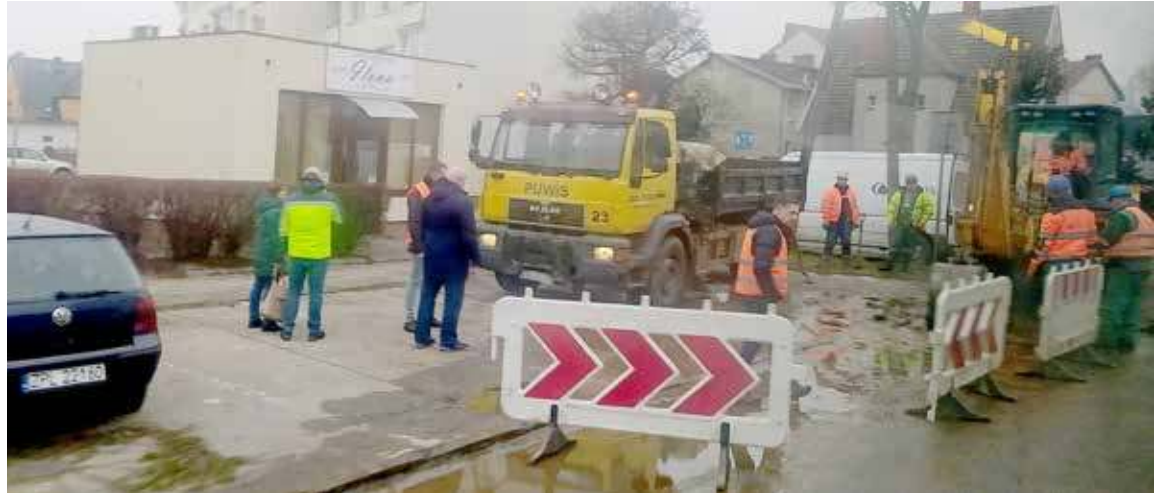
W czwartek od samego rana trwały prace przy ul. Stefana Żeromskiego
