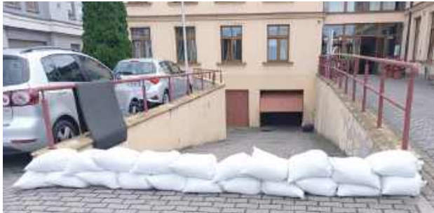
Barykada z worków broniąca urzędu przed wodą
