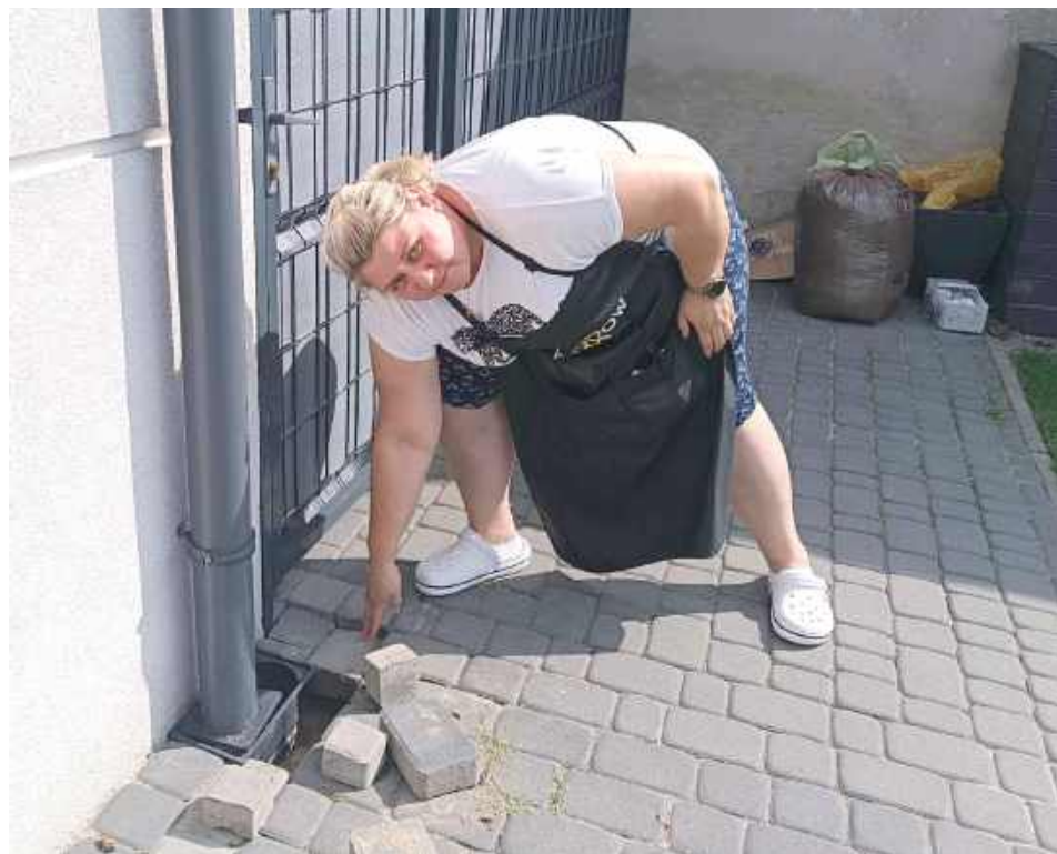
Woda wypłukowała kostki przy domu Arlety Komsty
