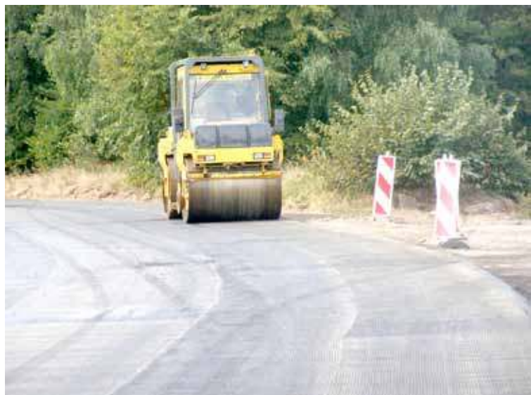
Powiat Stargardzki ubiega się o dofinansowanie na przebudowę drogi z Suchania do Słoddowa
